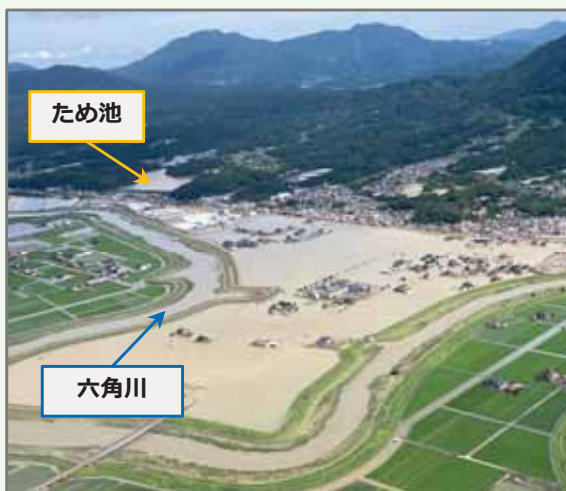
▲豪雨による被災状況
