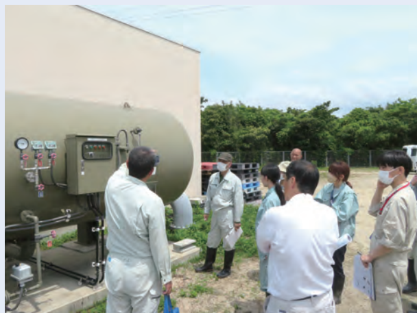
フォアスに水を送るポンプ施設の説明
