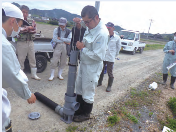
水位制御器の模型を使用した説明
