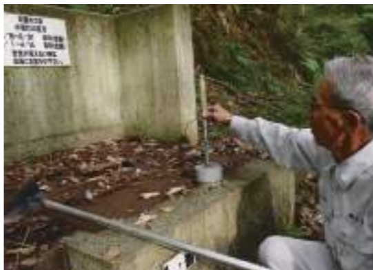
ちょうど取水口から水が運ばれて4km地点辺りで、パイプラインのなかを水が流れているか確認できる箇所がある。下に発砲スチロールの浮きをつけた棒（筆の柄の再利用）を水路に浮かべてあり、この棒の目印の位置によって、パイプ内の水の深さが外からわかる仕組みだ。水の深さは15〜19cmのところが良い。このアイデアも安村さんによるもの
