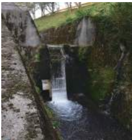
小水力発電は、旧向峠小学校（現在、通信制の松陰高校）の東側にある10号分水口から最後、深谷川へと落ちる水で行われている。月に2万5〜7千円ほどを中国電力に売電している
