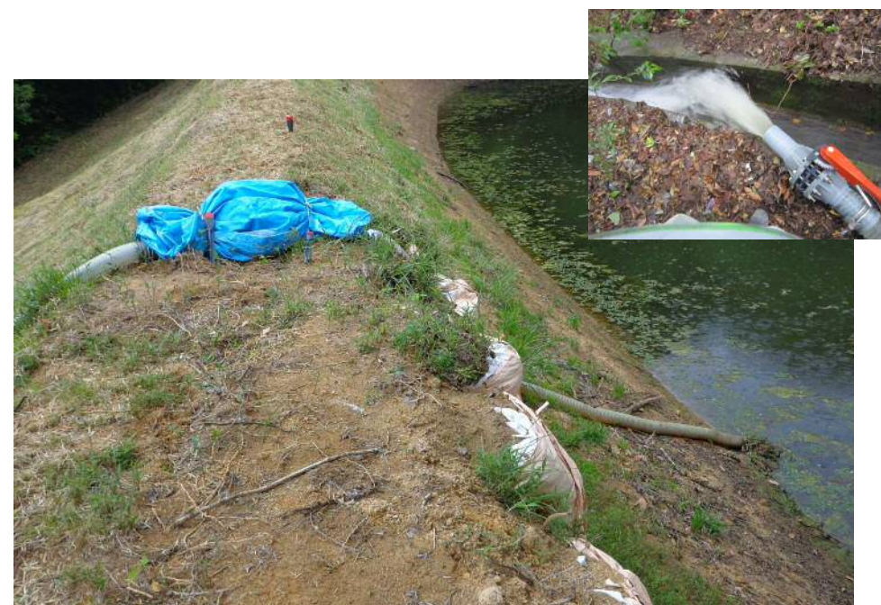
簡易サイフォンによる緊急排水
